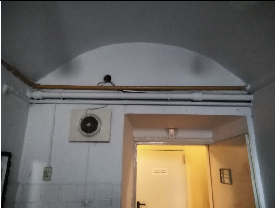
Pomieszczenie magazynowe nr 19a w piwnicy, pow. 0.1 – widok na kolebkę w której projektuje się przewiert z pom.1.2 pod przewody ze skroplinami
