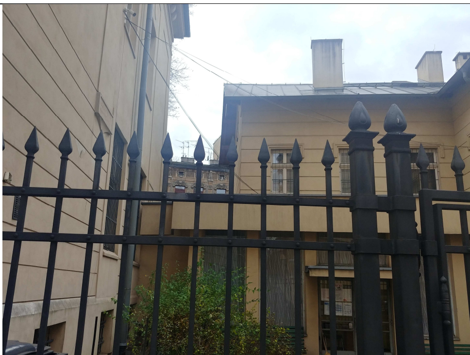
Widok na dziedziniec od strony ul. Asnyka i łącznik komunikacyjny pomiędzy budynkiem głównym, a oficyną – wnęka w której projektuje się montaż dwóch jednostek zewnętrznych jest częściowo przysłonięta istniejącą zielenią niską
