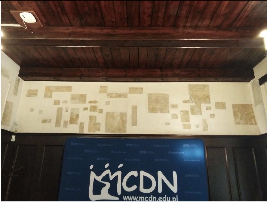
Sala wykładowa nr 2, pom. 1.1 – odkrywki na ścianie północnej (projektowana lokalizacja dwóch jednostek wewnętrznych, przewiercy na przewody zlokalizowane będą bezpośrednio za urządzeniami, średnica około 45mm)
