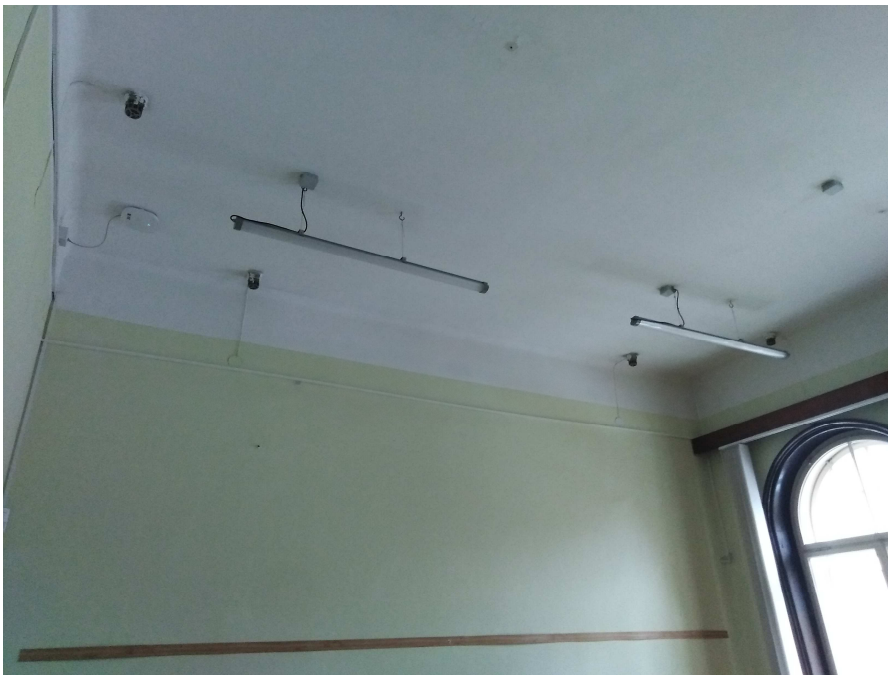
Sala na poczęstunek, pom. 1.4 – widok na ścianę zachodnią (projektowane przewody poprowadzone będą w przysufitowej belce maskującej 10x40cm) i narożnik północno-zachodni (projektowane przewody będą rozprowadzone po ścianie pod obudową w formie pilastra)
